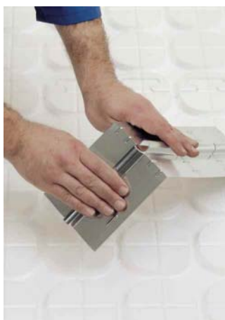
Teplotrozvodný modul s místem žádaného zlomu
